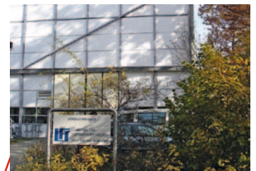
LFT VERSUCHSHALLE, HABERSTR. 9
